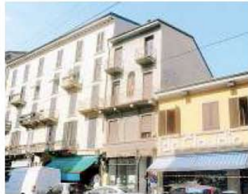
I palazzi di Ponte Vetro che saranno demoliti
