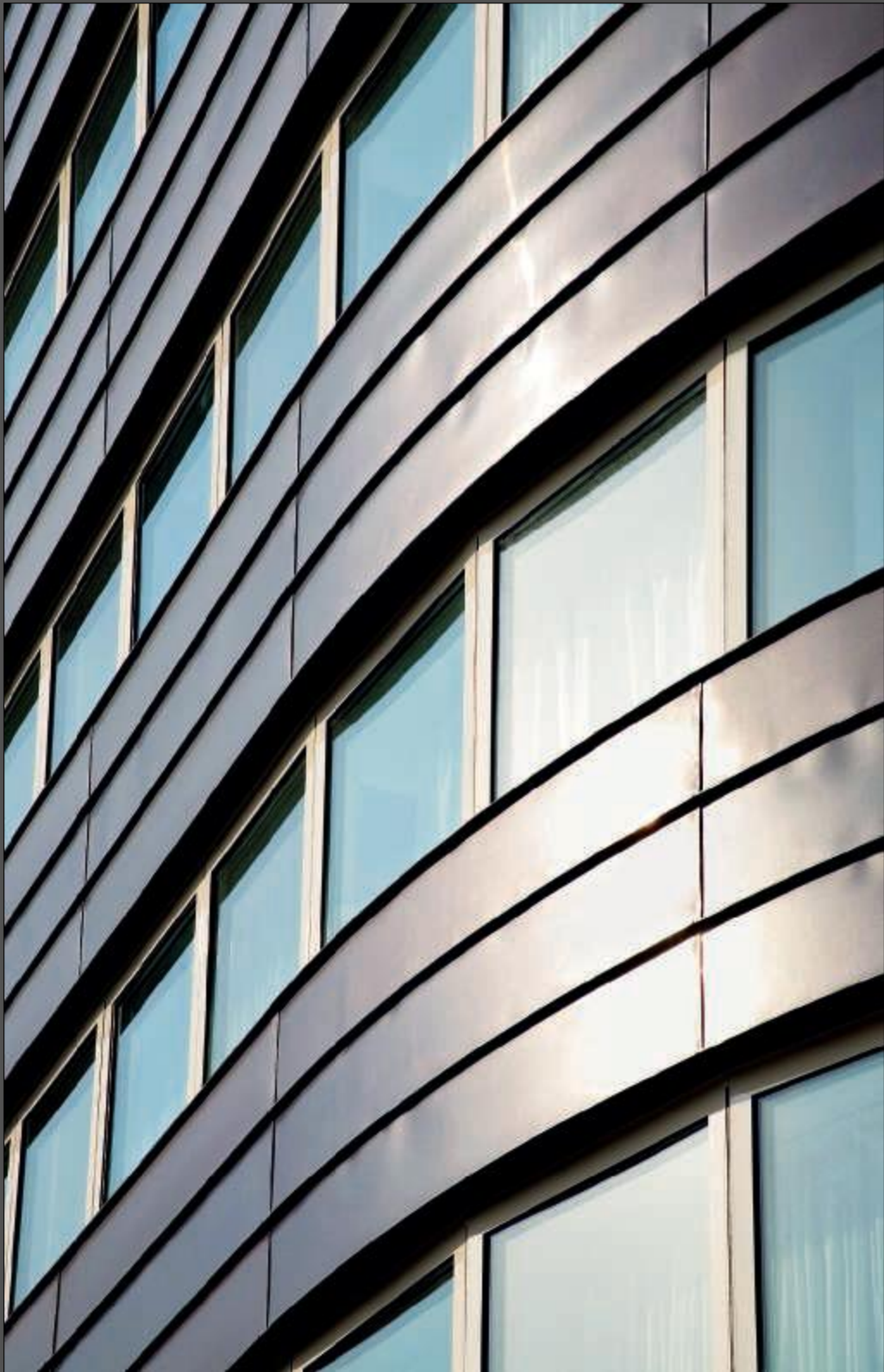
Particolare del rivestimento di rame in aggraffatura angolata
