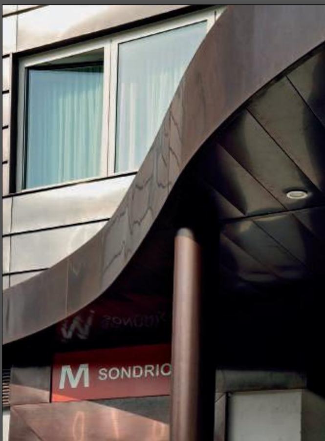
Particolare della pensilina d'ingresso e dei pilastri rivestiti in Tecu Oxid
